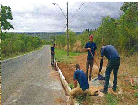
Manutenção e Conservação de Praças
